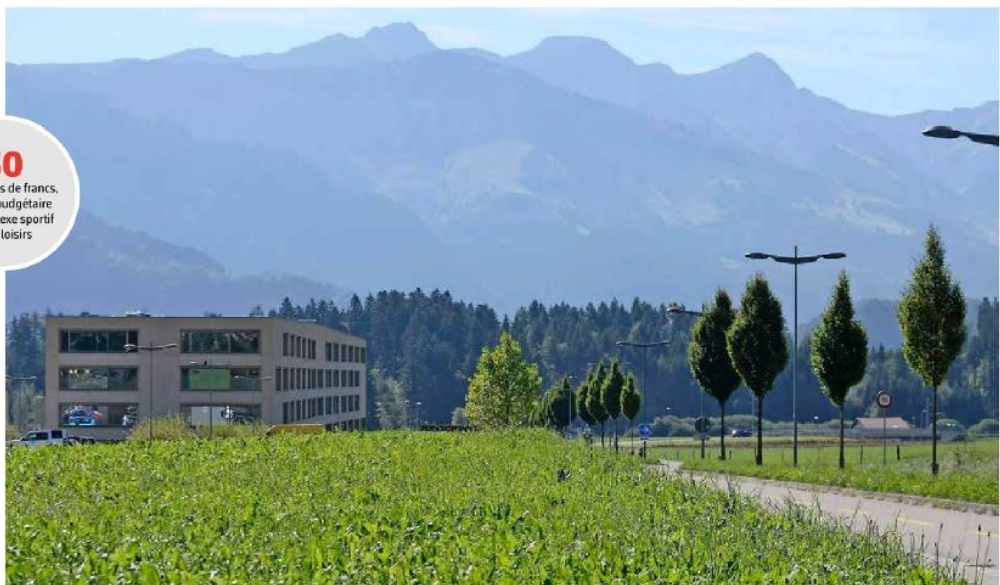
Le cahier des charges n'a pas changé: ce sont toujours une piscine, une patinoire et une halle triple (entre autres) qui prendront place près du CO de La Tour-de-Trême. Vincent Murith-archives
